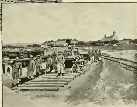
Legung des Oberbaues.
